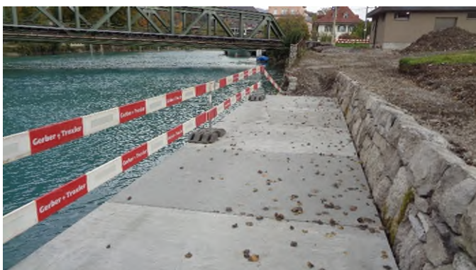
Abbildung 42 Neue Plattform mit entkoppelter Mauerteil im Englischen Garten
