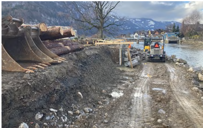
Abbildung 37 Bauausführung bei abgesenktem Wasserstand, Feb. 2022
