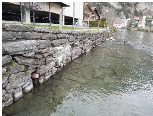
Abbildung 29 Schadenstelle nach Sanierung
