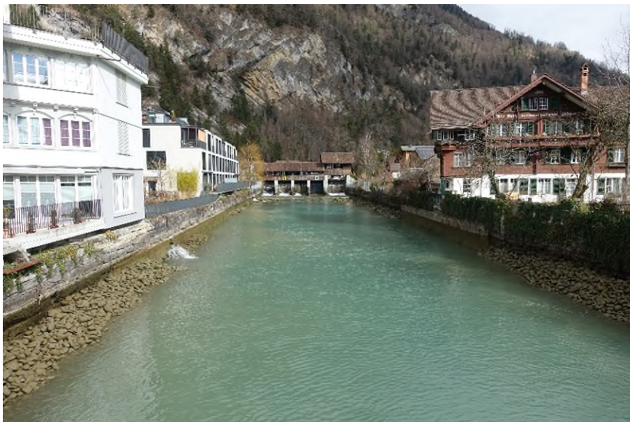
Abbildung 20 Vertikale Mauern in Grosser Aare (Obere Schleuse bis Marktgasse)
