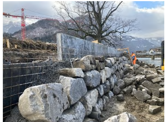
Abbildung 38 Aufbau der neuen Ufermauer, Feb. 2022
