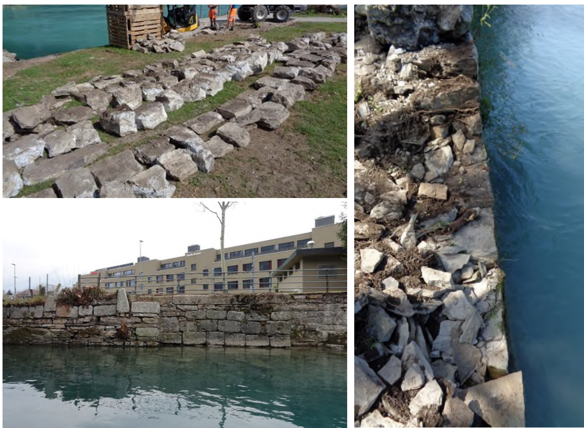
Abbildung 18 Teilrückbau der Ufermauer bei Englischen Garten 2019. Die Abbildung oben links zeigt das auf einem kurzen Abschnitt nicht mehr einheitliche Erscheinungsbild der Mauer. Unten links ist der für den Mauerbau verwendete Ringgenberger-Kalk ersichtliche. Rechts ist der Maueraufbau mit Filterschicht aus kantigem Steinmaterial abgebildet.
