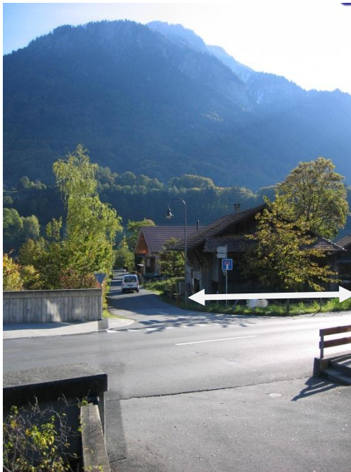
Abb. 30: Betonbordüren Kantonsstrasse (mit Kordon) und Standort der neuen Schutzmauer
