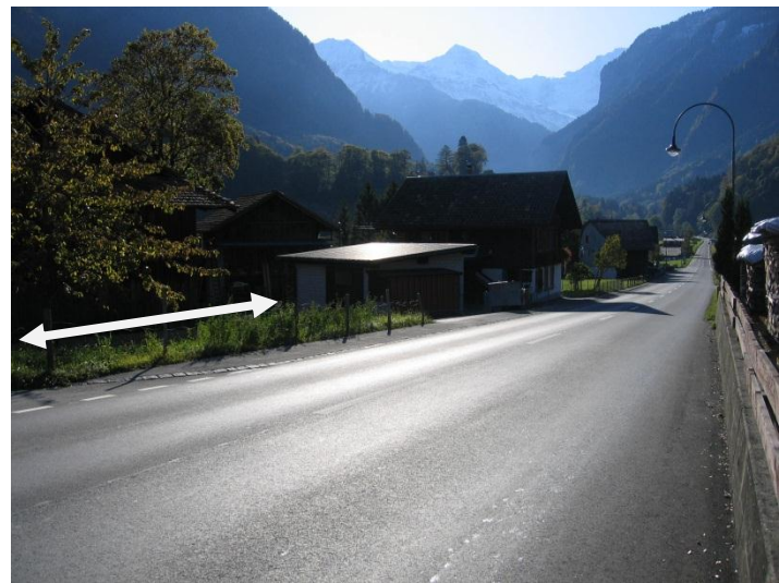
Mauer Terrasse Viktoria (rechts) und Standort Schutzmauer leicht zurückversetzt vom Trottoir
