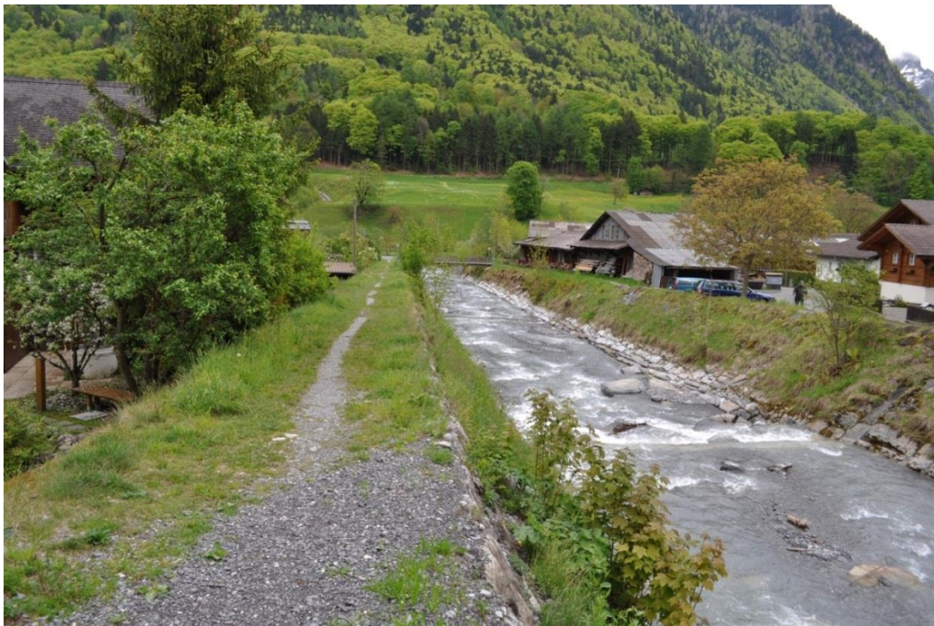
Abb. 13: Der Kanal des Saxetbaches unterstrom der Kantonsstrasse, Blick in Fließrichtung
