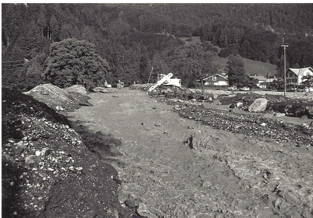
Abb. 8: Der Saxetbach mobilisiert grosse Geschiebemengen bei Hochwasser
